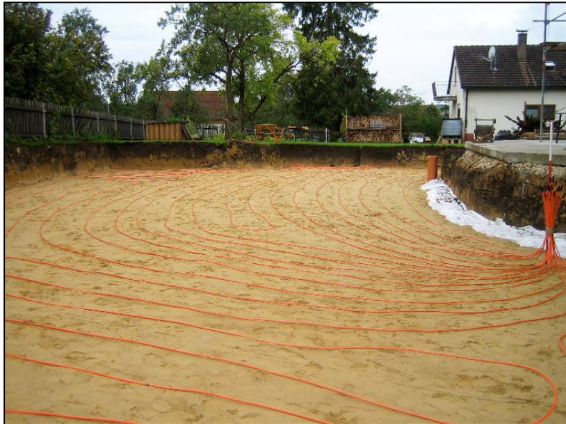
Als Kaltquelle der Wärmepumpe dient ein horizontales Flächenregister. In einer Tiefe von etwa einem Meter entziehen neun kunststoffummantelte Kreisleitungen aus Kupfer mit einer Gesamtlänge von 630 m auf einer Bodenfläche von 300 m<sup>2</sup> dem Erdreich die Wärme. In den Erdreich-Registern zirkuliert direkt das Kältemittel der Wärmepumpe. Eine Sommerkühlung des Hauses wie bei einer Erdsonde mit einem Wasser-Glykolgemisch ist bei solch einem Direktverdampfersystem nicht möglich.
