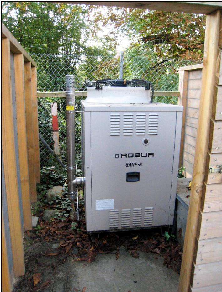
beim Kühlschrank. Der schafft Wärme aus seinem Inneren ins Äußere. Die Wärmepumpe arbeitet genauso, jedoch mit umgekehrtem Nutzen: Sie „pumpt“ die Wärme von außen in das Innere des Hauses und stellt diese für die Heizung und das Brauchwasser zur Verfügung.
