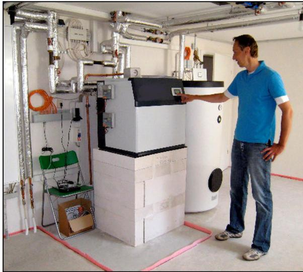
2 °C und Heizungsvorlauftemperatur 35°C). Besondere Merkmale sind der vollmodulierende Verdichter mit variabler Leistung zwischen 3 bis 14 kW-thermisch), die Umkehrkühlung und der Energiesparregler. Es handelt sich um ein Split-Gerät mit einem Verdampfer im Außenbereich.
