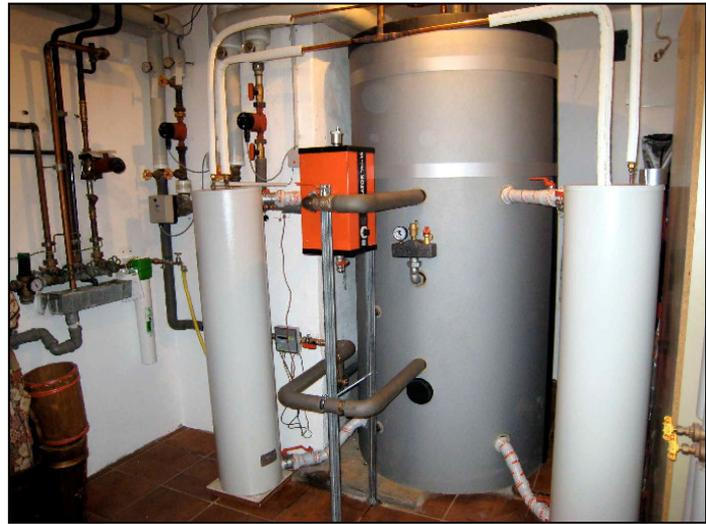
Die Luft-Wärmepumpen beheizen Ein- und Zweifamilienhäuser im Schwarzwald. Es handelt sich um Altbauten, die aber auf einen Niedrigenergiehaus-Standard gedämmt sind. Die Wärmepumpe mit der Nummer 2103 beheizt eine Fläche von 310 m<sup>2</sup> mit Hilfe einer Fußbodenheizung und Radiatoren und die mit der Nummer 2104 230 m<sup>2</sup> mit Radiator-Heizkörpern.
