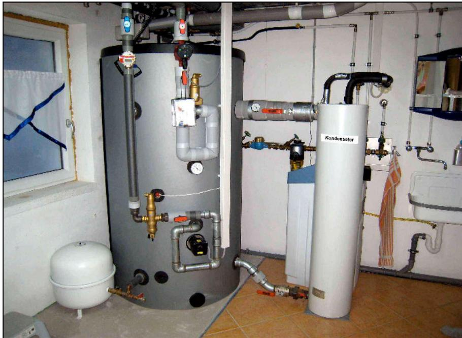
noch einen 200 Liter Boiler für das Trinkwasser beinhaltet (Foto links WP-Nr. 2104 der Familie Schmidt in Dornhan). Der Kondensator gibt die Wärme des Kältemittels nicht direkt an den Kombispeicher ab, sondern über einen Schwerkraft- oder Naturumlauf (Thermosiphon).
