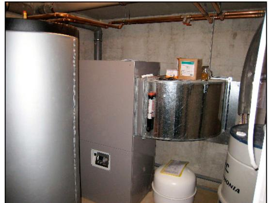
Die Wärmepumpe beheizt ein Einfamilienhaus mit einer Fußbodenheizung in Lahr (mittlerer Schwarzwald). Es handelt sich um ein Niedrigenergiehaus aus dem Jahre 2009 mit einer beheizten Fläche von 243 m<sup>2</sup>. Der berechnete Heizwärmebedarf beträgt 48 kWh-thermisch pro m<sup>2</sup> Wohnfläche und Jahr. Das Haus bewohnen zwei Erwachsene und zwei Kinder.
